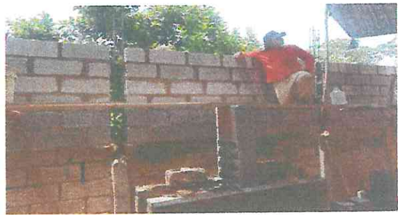
Foto 4: Levantado de muro en parte norte
