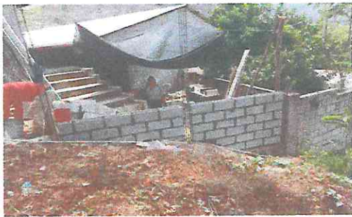
Foto 5: Trabajos de levantado de muro en ubicación Este.
