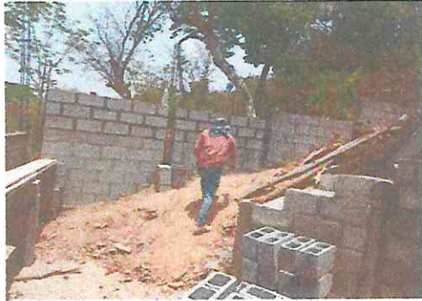
Foto 1: Trabajos en muro sector Este
