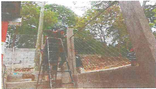
Foto 3: Colocacion de material de cierre en muro perimetral
